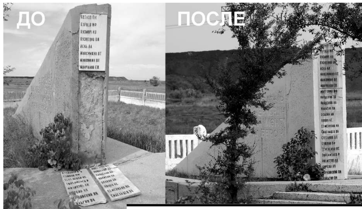
ПО ПОРУЧЕНИЮ АКИМА КАРАГАНДЫ МЕСТНЫМИ ВЛАСТЯМИ НА ТЕРРИТОРИИ МОНУМЕНТА БЫЛИ ПРОВЕДЕНЫ РЕМОНТНО-ВОССТАНОВИТЕЛЬНЫЕ РАБОТЫ И БЛАГОУСТРОЙСТВО.
