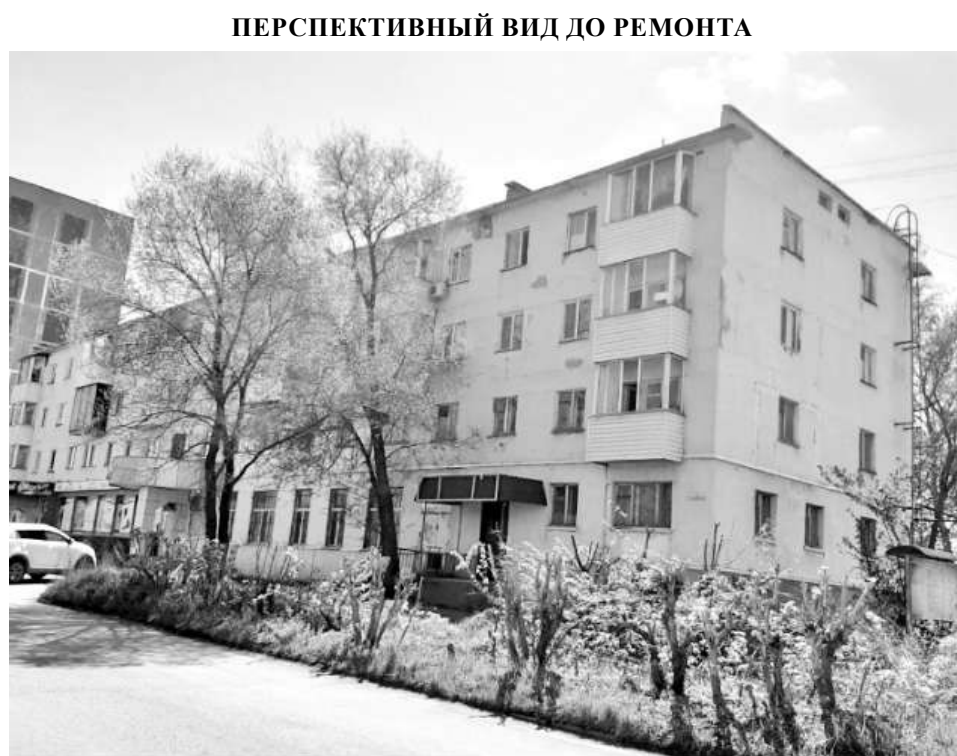
ПЕРСПЕКТИВНЫЙ ВИД ДО РЕМОНТА
